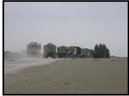
Fotografía N° 01: Transporte de escombros hacia el botadero, mediante el uso de volquetes.
