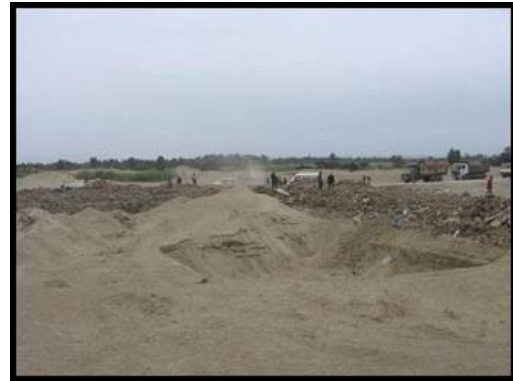
Fotografía N° 02: Material de escombros dispuesto en el botadero conformando los terraplenes finales.
